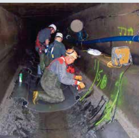
Montage des Wärmetauschers in einem öffentlichen Abwasserkanal in Stuttgart-Bad Cannstatt
